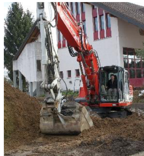
Bereits in den ersten Januartagen fuhr der Bagger auf.
