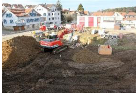
Bei gutem Wetter beginnen die Aushubarbeiten.
